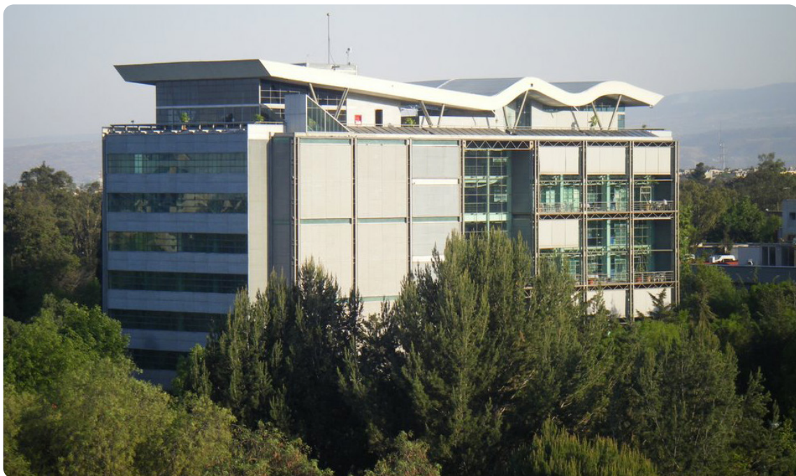
| Torre de Ingeniería
